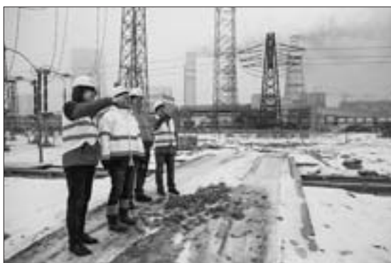
中资企业积极参与“一带一路”沿线中东欧国家的基础设施建设。图为1月27日，中国和波兰两国工程师在位于波兰东南部的科杰尼采电站重建项目施工现场工作。（摄影 陈序）
